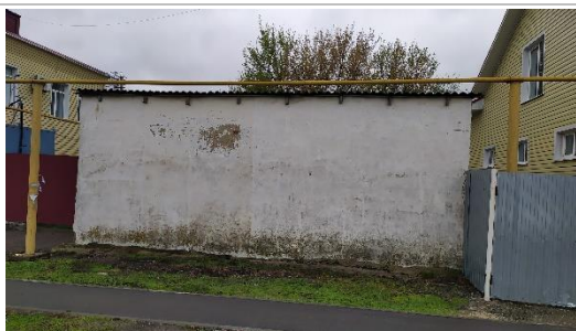
Фотография 3.1. Внешнее состояние объекта
