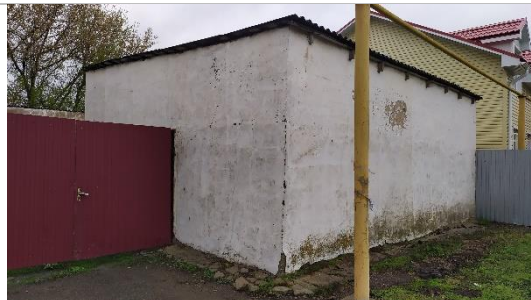
Фотография 3.2. Внешнее состояние объекта
